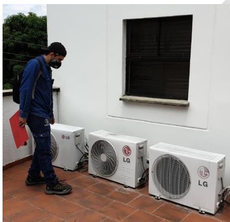
Mantenimiento correctivo y preventivo de AA.
