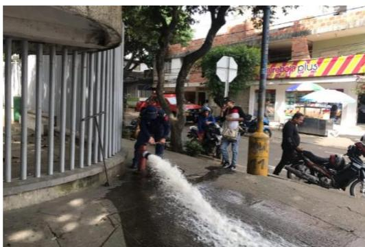
**Fotografía 2. Medición caudal y presión hidrante inspeccionado Carrera 33 No.30ª esquina**
